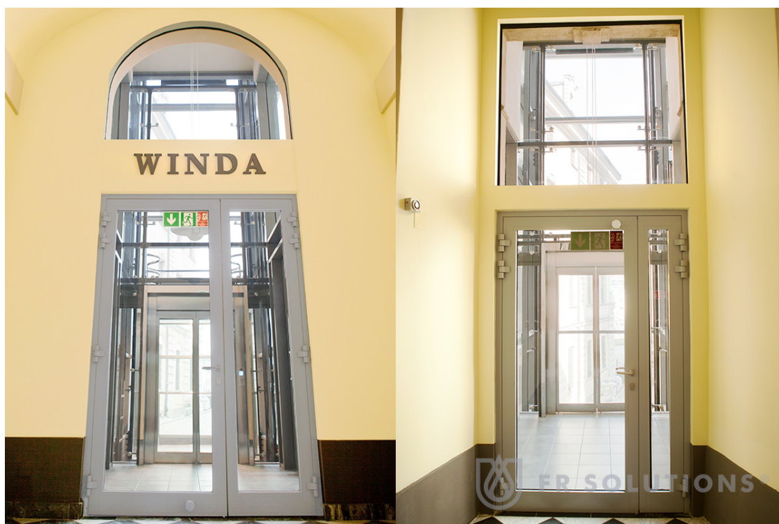
W budynku Uniwersytetu Wrocławskiego zastosowano system FR w klasie EI 120. Wąski korytarz zyskał dzięki temu dużo światła
