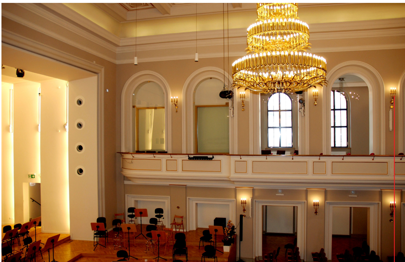
Požární sklo Polflam umístěné v obloucích chrání nahrávací studio Slezské filharmonie, které se nachází hned za zdí, a zároveň zajišťuje potřebnou úroveň zvukotěsnosti.
