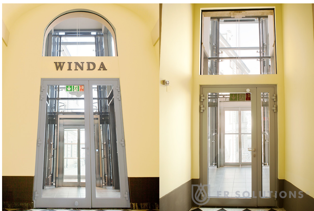
Na budově Vratislavské univerzity byl použit systém FR v třídě EI 120. Úzká chodba díky tomu získala hodně světla.
