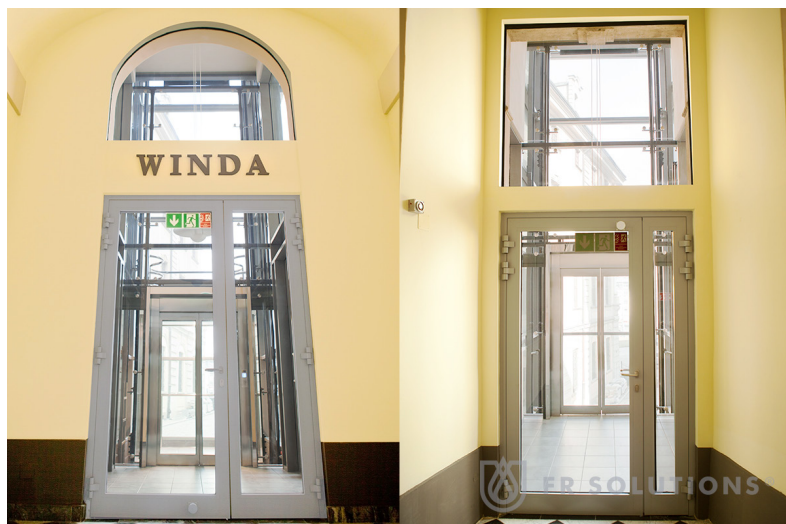
В здании Вроцлавского университета использовалась система FR класса EI 120, что позволило создать хорошо освещенный узкий коридор
