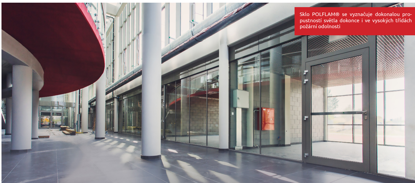
Na fotografii: sklo POLFLAM® v protipožárních příčkách velkých rozměrů montované v bezrámovém systému. Mediatéka 21. století, Tychy
