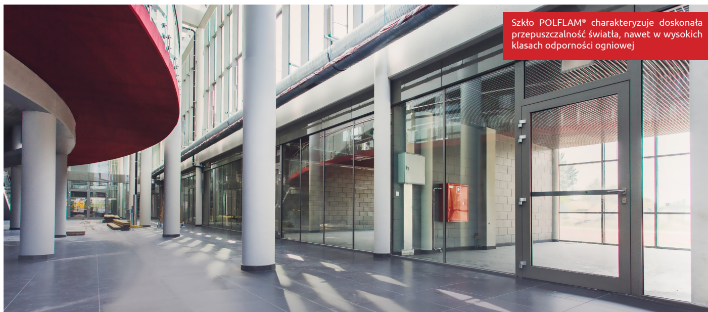
Na zdjęciu: szkło POLFLAM® w przegrodach ogniochronnych o dużych powierzchniach, zamontowane w systemie bezramowym. Mediateka XXI wieku w Tychach
