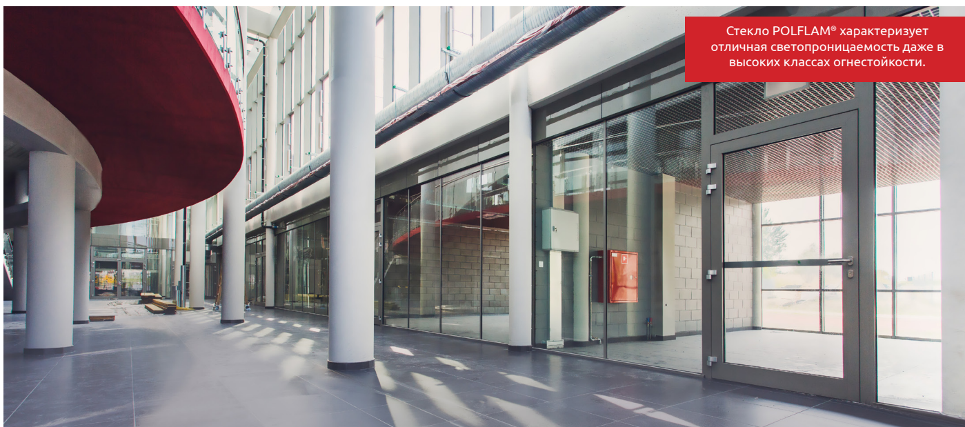
На фото: установленное на базе безрамной системы стекло POLFLAM® в огнестойких перегородках с большой поверхностью. Медиатека XXI века в г. Тыхы.
