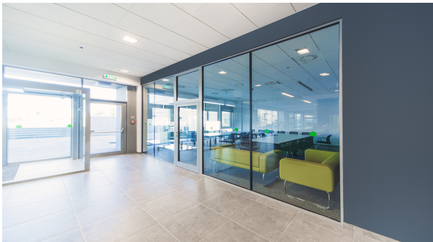
System BR umožňuje efektivní kombinování tabule průhledného skla, neprůhledného skla a dveří nezařazených do žádné třídy nebo s požární odolností.
