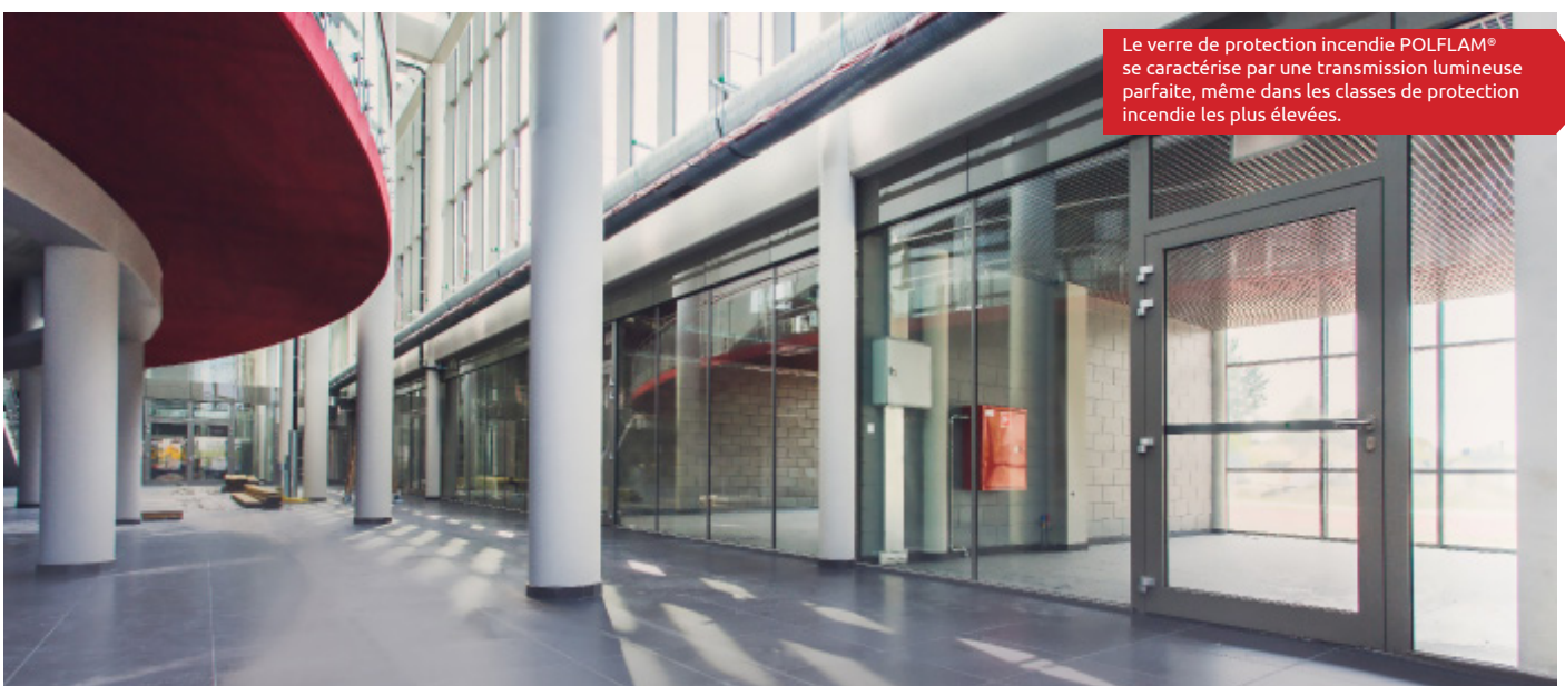
L'illustration montre le verre POLFLAM ® intégré dans des parois de séparation coupe-feu de grande surface dans un système sans cadre. Médiathèque 21 à Tychy
