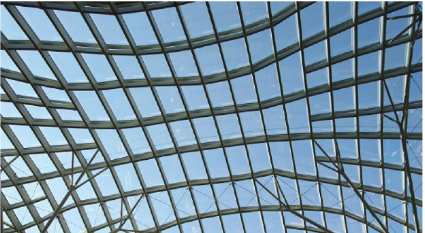
*In die Konstruktion können Scheiben aus POLFLAM<sup>®</sup>-Brandschutzglas mit Abmessungen von bis zu 2654 x 1174 mm eingesetzt werden.*
