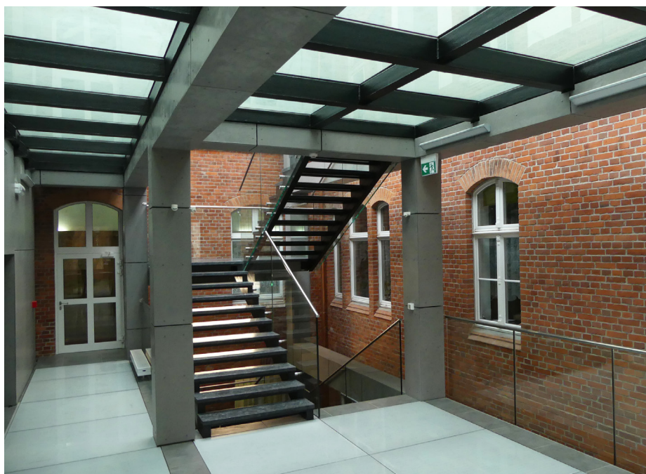
▼ Hudební škola Oskara Kolberga v Szczecinku. Do stropů dvou podlaží schodiště bylo zabudováno sklo POLFLAM ® F REI 60.
