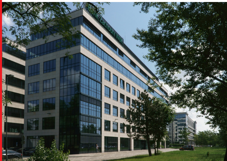
Bank Zachodni WBK – centrála ve Vratislavi. Sklo POLFLAM bylo použito v fasádě budovy s požadovanou požární odolností
