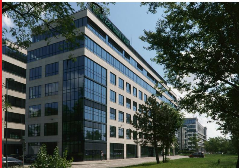
Bank Zachodni WBK – Zentrale in Wrocław. POLFLAM-Brandschutzglas wurde in der Fassade mit der verlangten Feuerbeständigkeit verwendet
