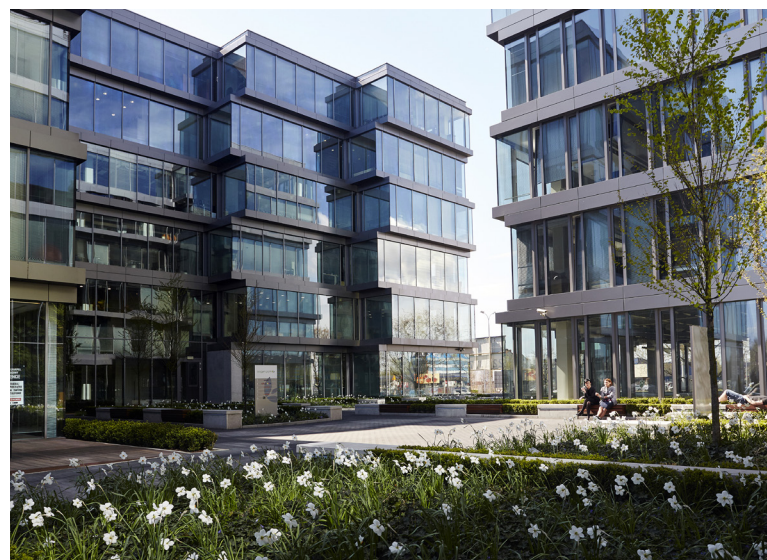
Verre POLFLAM dans la façade de Oxygen Park: un immeuble de bureaux moderne dans un quartier d'affaires de Varsovie
