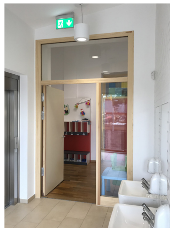
Огнестойкое стекло POLFLAM® в дверях и деревянных витражах с натуральной отделкой в помещениях школы в коммуне Кейл, г. Люксембург
