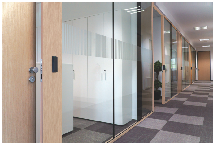
Пример применения стекла POLFLAM® BR в современном офисе – безрамный монтаж с деревянным отделочным профилем, выполненный в стиле минимализма
