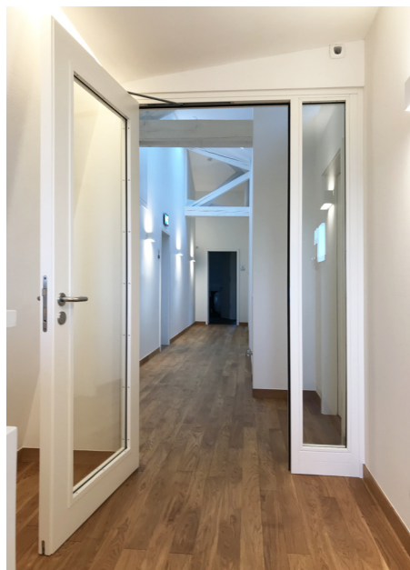
В объекте одного из люксембургских министерств огнестойкое стекло POLFLAM® установлено в деревянных монтажных конструкциях
