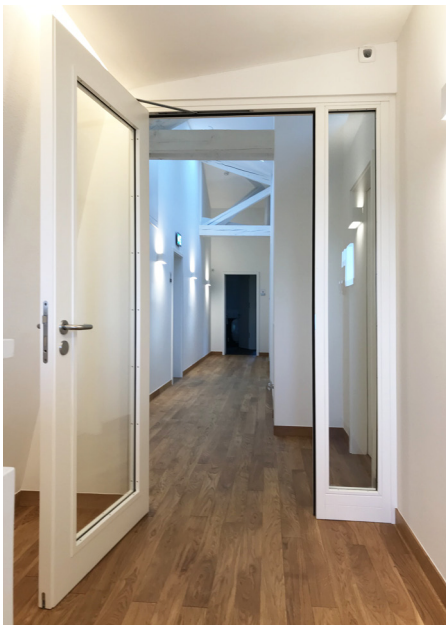
POLFLAM®-Brandschutzglas im Holzrahmensystem in den Räumlichkeiten eines luxemburgischen Ministeriums
