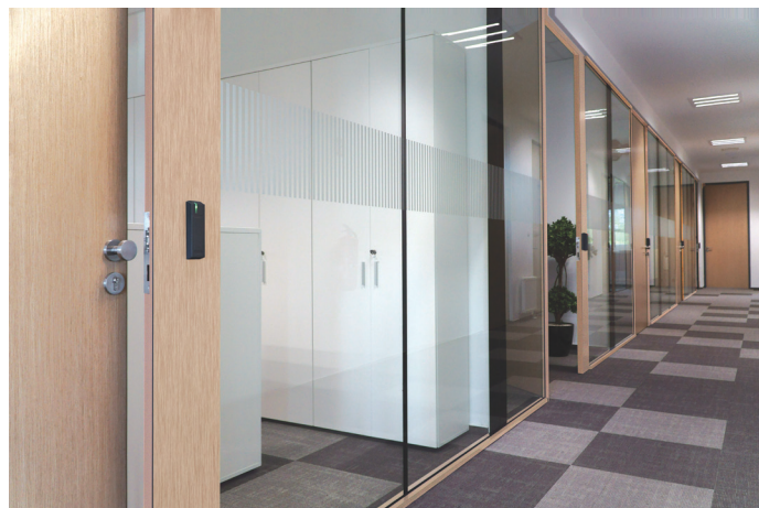
Anwendungsbeispiel von POLFLAM®-Brandschutzglas BR im rahmenlosen System mit minimalistischen Holzleisten in einem modernen Bürogebäude
