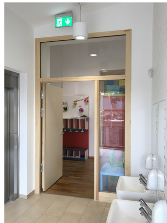
POLFLAM®-Brandschutzglas im natürlichen Holzrahmensystem in den Türen und Innenverglasungen eines Schulgebäudes im luxemburgischen Kayl
