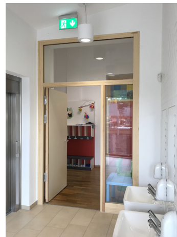
Protipožární sklo POLFLAM ® v dřevěných dveřích a prosklených stěnách s přirozeným vzhledem povrchových úprav v prostorách školy Kayl v Lucembursku
