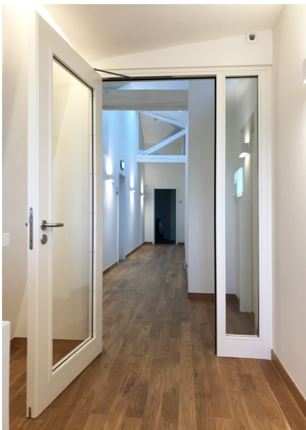
▲ V objektu jednoho z lucemburských ministerstev bylo protipožární sklo POLFLAM ® založeno v dřevěných dveřích
