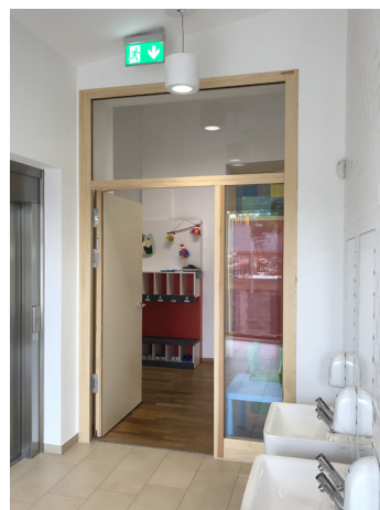
Szkło ogniochronne POLFLAM® w drzwiach i witrynach drewnianych o naturalnym wykończeniu w pomieszczeniach szkoły w Kayl w Luksemburgu
