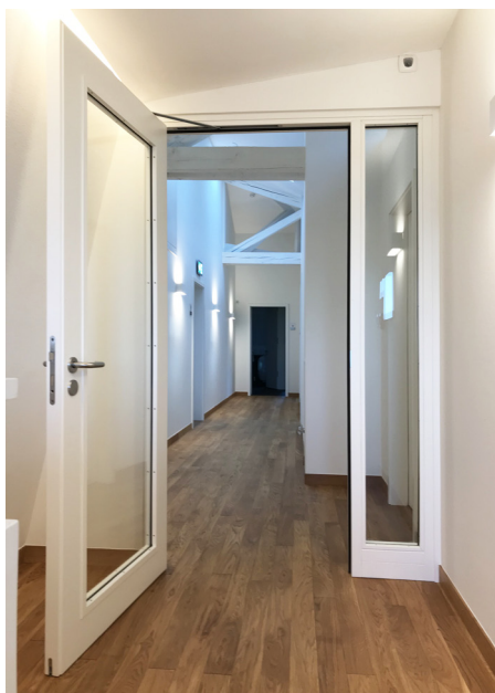
▲ W obiekcie jednego z luksemburskich ministerstw szkło ogniochronne POLFLAM® zamontowane zostało w stolarce drewnianej
