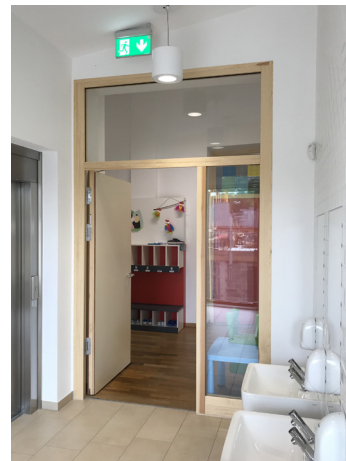
Verre de protection incendie POLFLAM ® installé dans un système de cadre en bois naturel dans les portes et vitrages intérieurs d'un bâtiment scolaire à Kayl, Luxembourg. ◀
