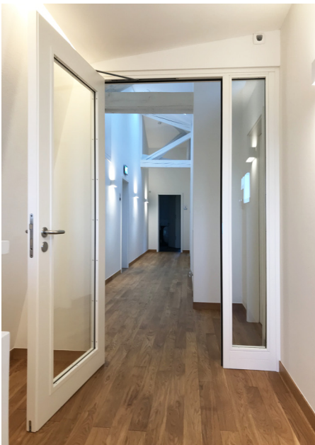
▲ Verre de protection incendie POLFLAM ® installé dans un système de cadre en bois dans les locaux d'un ministère luxembourgeois
