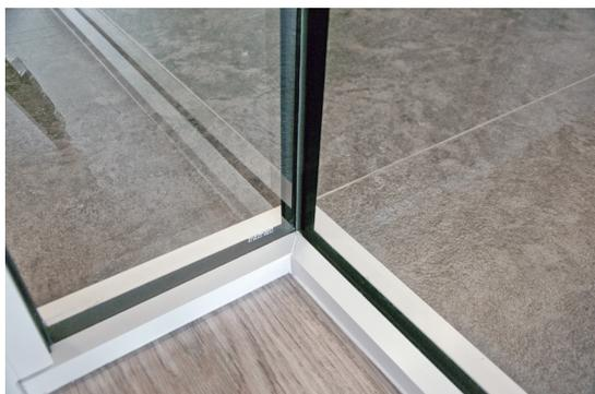
*Mit dem rahmenlosen System lassen sich Innenverglasungen ohne sichtbare vertikale Profile herstellen, durch die die einzelnen Scheiben getrennt sind.*
