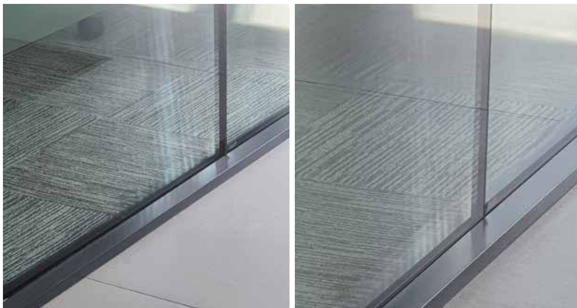
Obr. 8. Příklad jevu anizotropie v tvrzeném skle.
