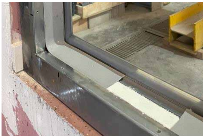
Obr. 5. Protipožární zpěňující pásy umístěné na dolní část profilu
