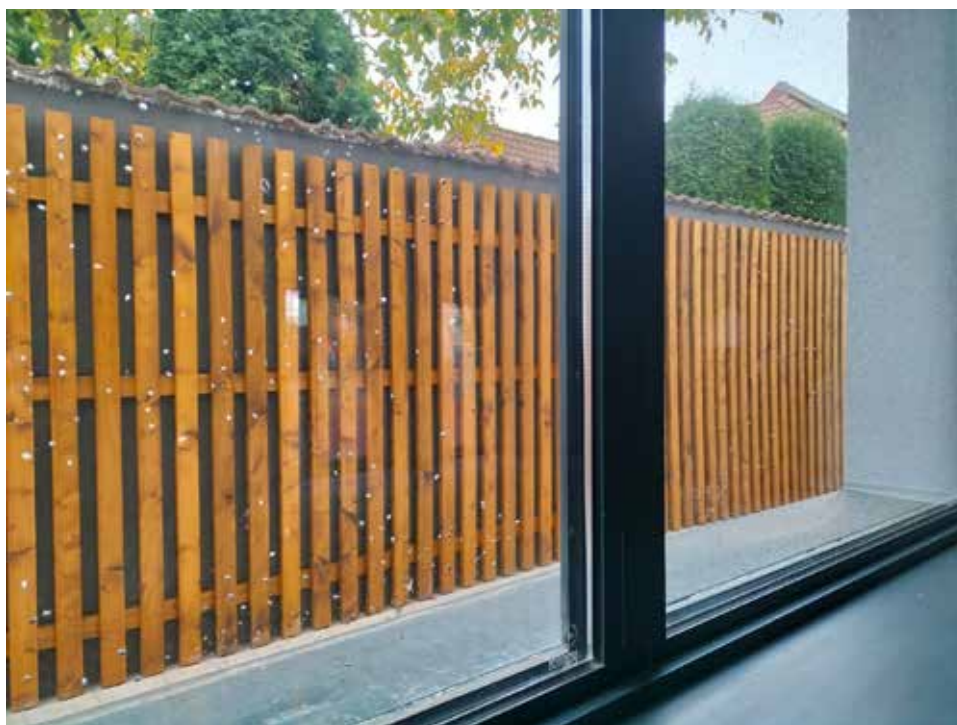
Obr. 11. Přehřátí protipožární tabule skla
